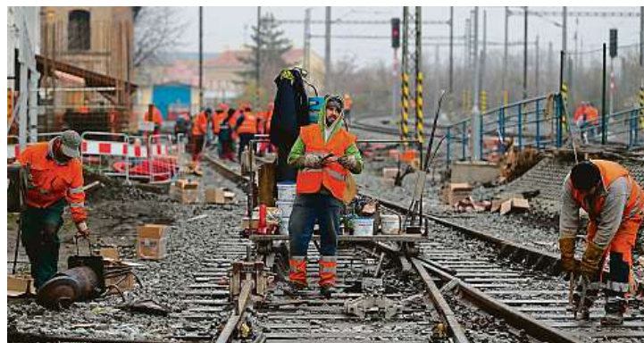
Na dolním nádraží ještě pracují dělníci. Do týdne dokončí koleje, podchod i novou čekárnu.
